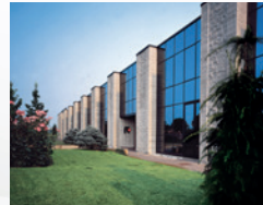
Usine de Pavie : IT Cooling
