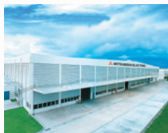
Usine de Chonburi en Thaïlande
